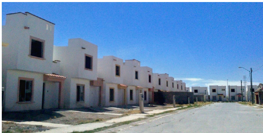
Imagen 3. Viviendas deshabitada en el fraccionamiento Los Arcos.
