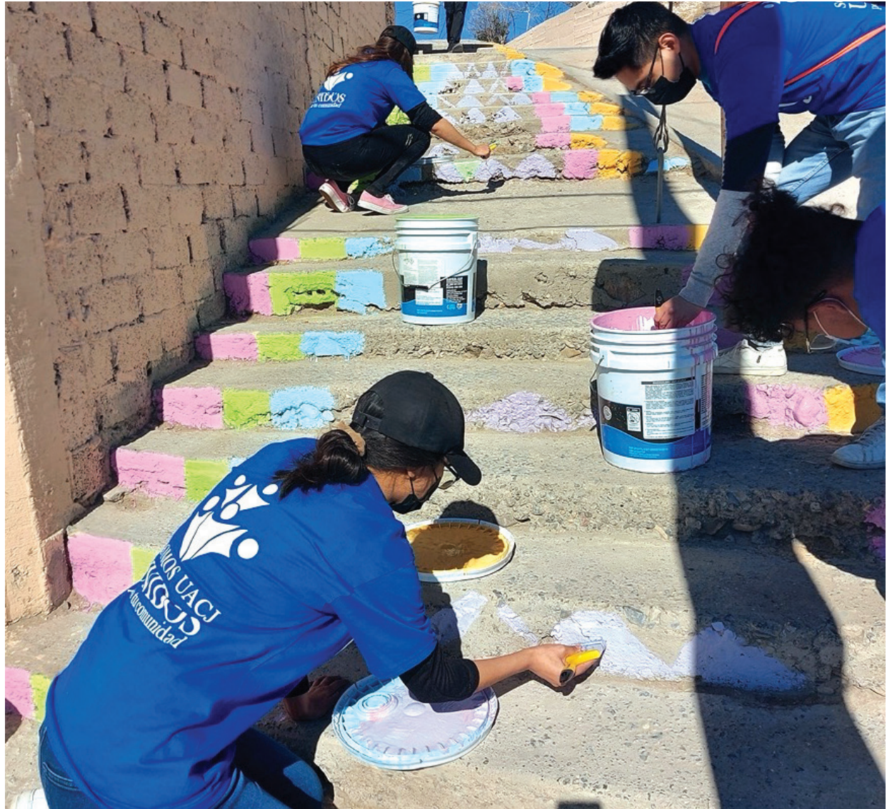
Estudiantes realizan mejoras en la estructura urbana de la colonia Felipe Ángeles.
