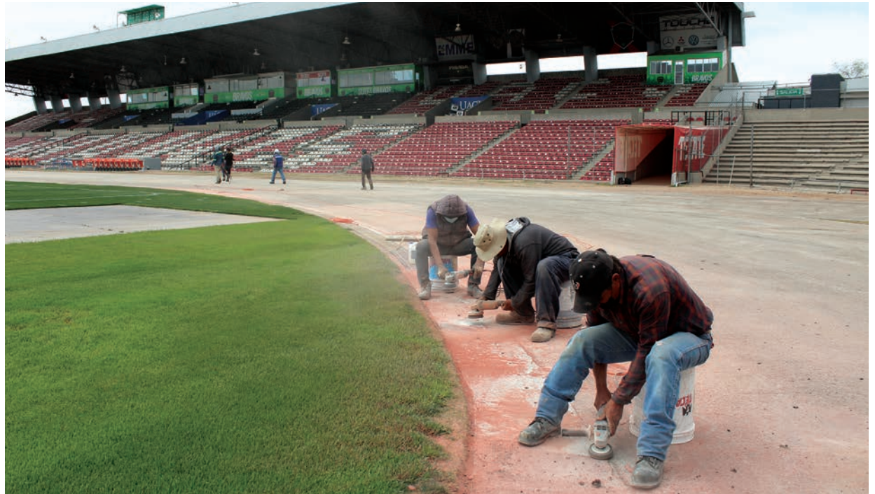
Trabajadores se dan a la tarea de preparar la superficie para la instalación de la nueva pista.
