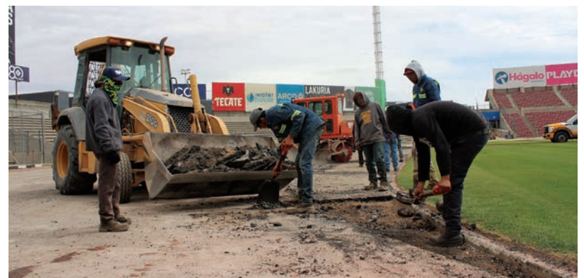
Una cuadrilla de trabajadores retira material con palas y maquinaria.
