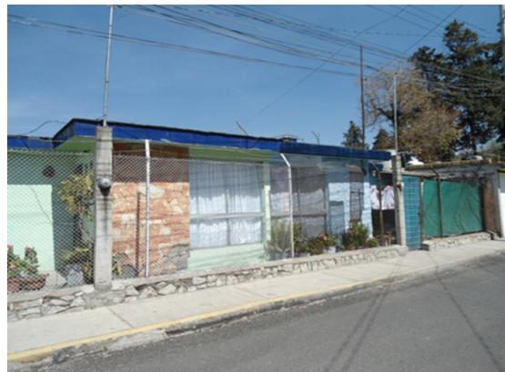
Imagen 10. Vista actual de las viviendas de los Ferrocarrileros de la Estación Nueva de Puebla
