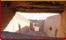
muros gruesos por el ancho del adobe, en este caso los muros de la vivienda del Sr. Camargo miden más de 60 centímetros, y está colocado en forma cuatrapeada. La vivienda tiene una puerta que comunica inmediatamente hacia la cocina que está orientada hacia el sur. La puerta contiene una pequeña techumbre como un alero de material pajizo. Las ventanas son rectangulares con la función principal de iluminar el interior de las habitaciones (ver imagen 2.2.).
