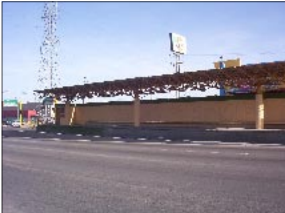
Figura 5. Los paramentos sólidos en lugares de riesgo los hace inseguros y favorecen la realización de actos de delincuencia
