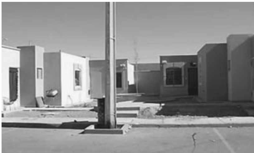
Figura 1. Vivienda de interés social tipo económica organizada en régimen de condominio, con una superficie privativa de 41.20 m 2 y 30.70 m 2 de superficie.
