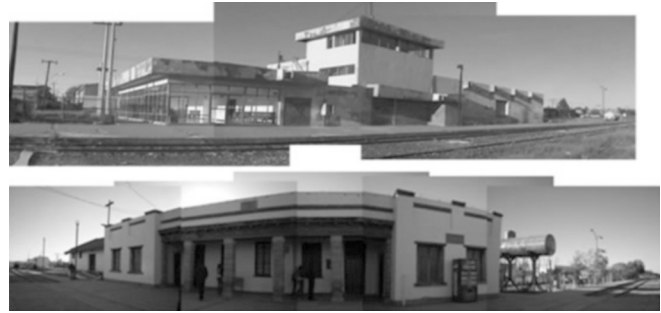
Figura 3. Vista de Estación de La Junta y de la Estación de Nuevo Casas Grandes, (Peña, 2008).
