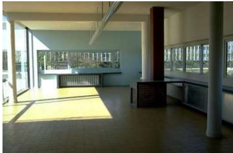
Imagen 8. Vista sobre la planta libre del salón-comedor y fachada flotante ( www.brynmawr.edu )
