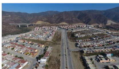
FIGURA 2. Vista panorámica de un segmento de caso A- Los Encinos
