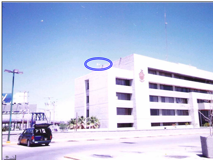
Fig. 6. Sensor de Estación de monitoreo Protección Civil.
