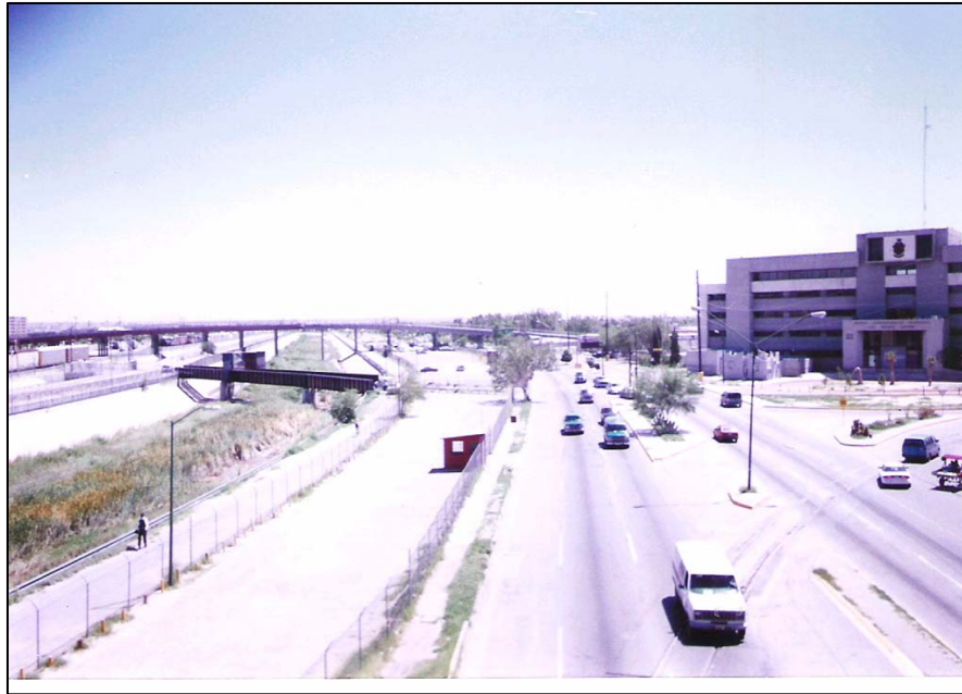
Fig. 5. Estación de monitoreo Protección Civil.
