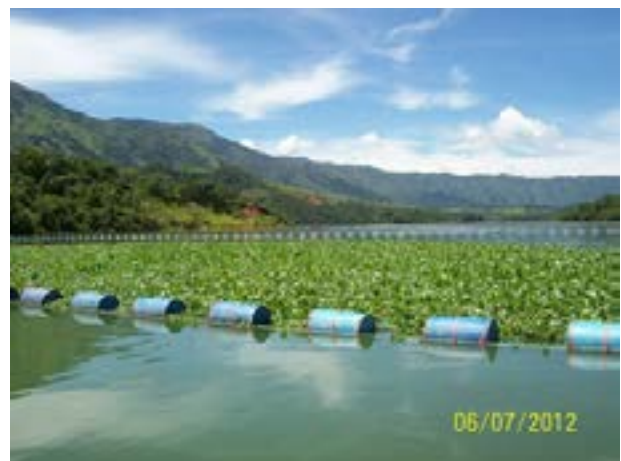
Foto 1. Barrera y biofiltro, vista cerca. Fuente: foto EPM.
