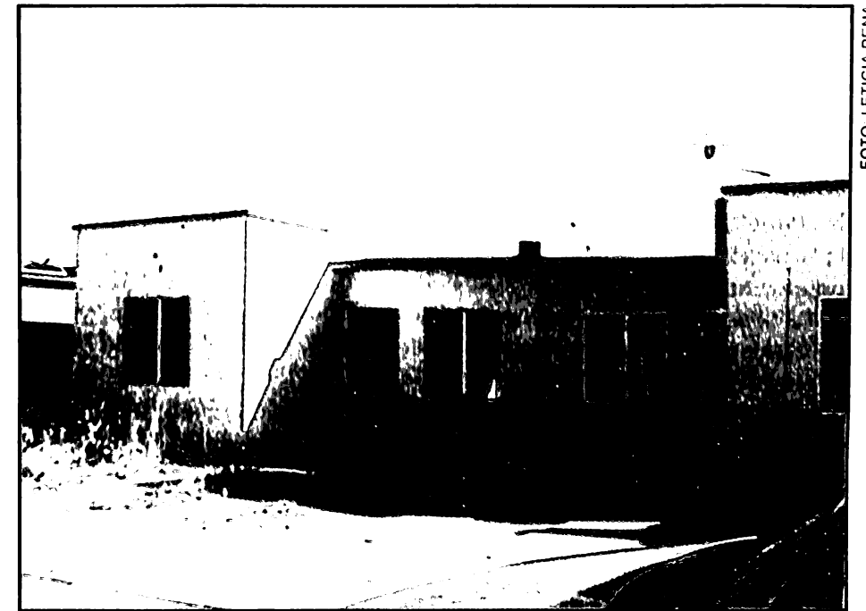
Foto 1. Vivienda desocupada en Riberas del Bravo.
