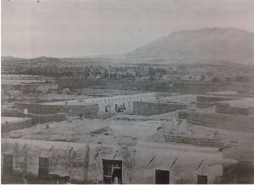
Figura 3. Vista de Villa Paso del Norte
