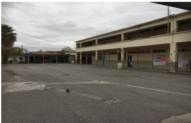
Imagen 1. Vista de fachada poniente
