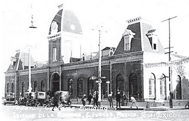
Figura 6. Vista del edificio de la Ex-Aduana de Ciudad Juárez. 2
