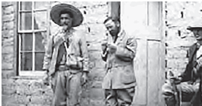
Figuras 1 y 2. Imágenes de la casa de adobe. 1
